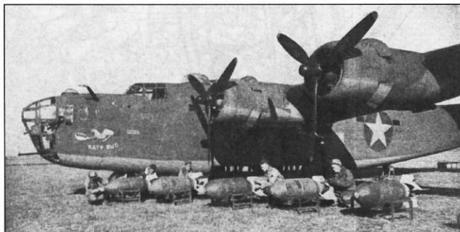
Типичная бомбовая нагрузка В-24 – пять 454-кг бомб
